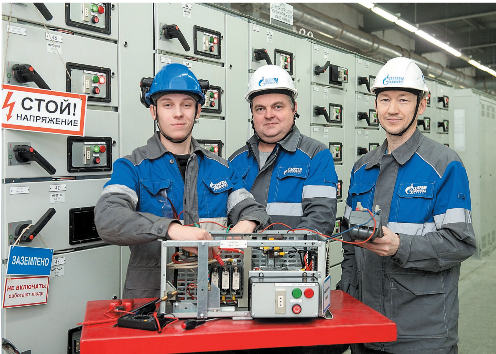
Электромонтер цеха технического обслуживания и ремонта электрооборудования (ЦТО и РЭО) завода «Мономер» Илья Барабанченко, заместитель начальника ЦТО и РЭО завода «Мономер» Алексей Кириллов, начальник участка № 4 ЦТО и РЭО Рамиль Файзуллин
