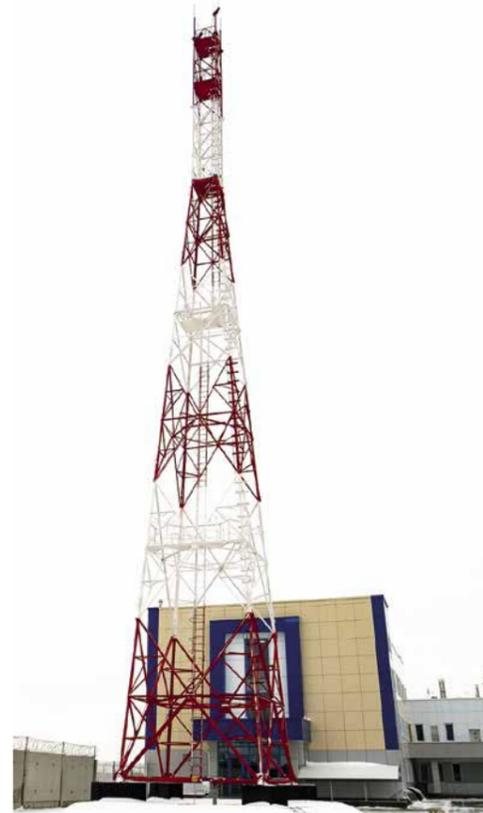
В рамках проекта построена цифровая радиорелейная линия связи с антенно-мачтовым сооружением высотой 45 метров
