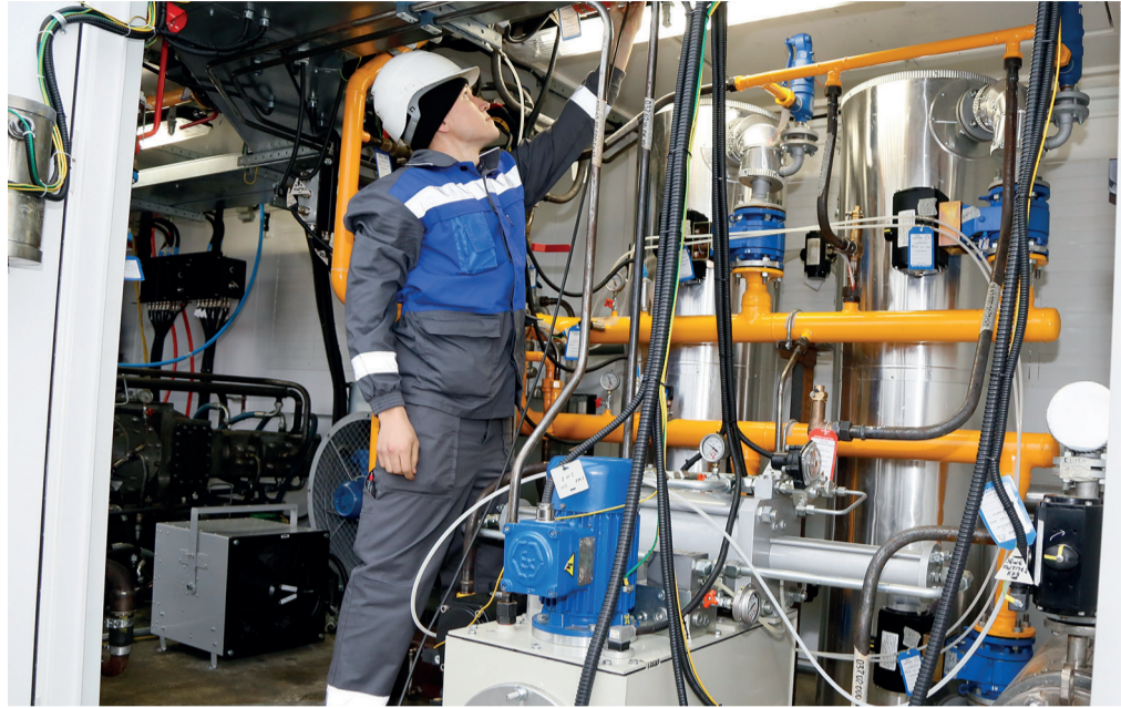
Проверка работоспособности объекта
