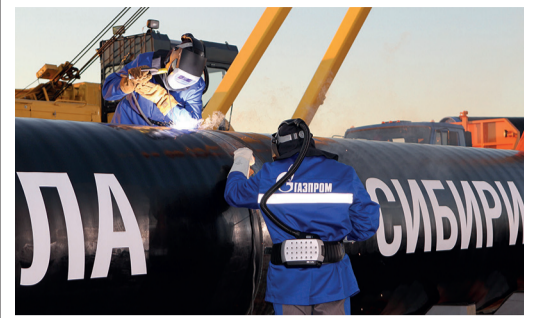
Сварка первого стыка газопровода «Сила Сибири»
