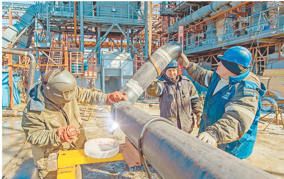
Помимо чистого водорода, установка будет вырабатывать остаточный газ, который будет подаваться в топливную сеть компании
