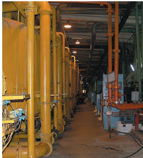
В помещении химводоочистки № 1 химического цеха после проведенной реконструкции стало значительно светлее. Для сравнения: на снимке слева – то, как было, на снимке справа – стало
