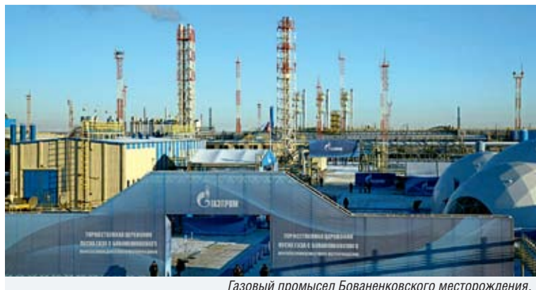
Газовый промысел Бованенковского месторождения.
