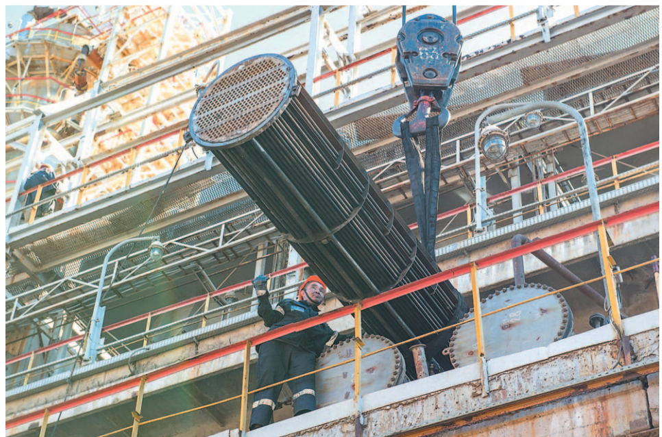
Монтаж трубных пучков теплообменников на блоке № 4 установки ЭЛОУ АВТ-4
