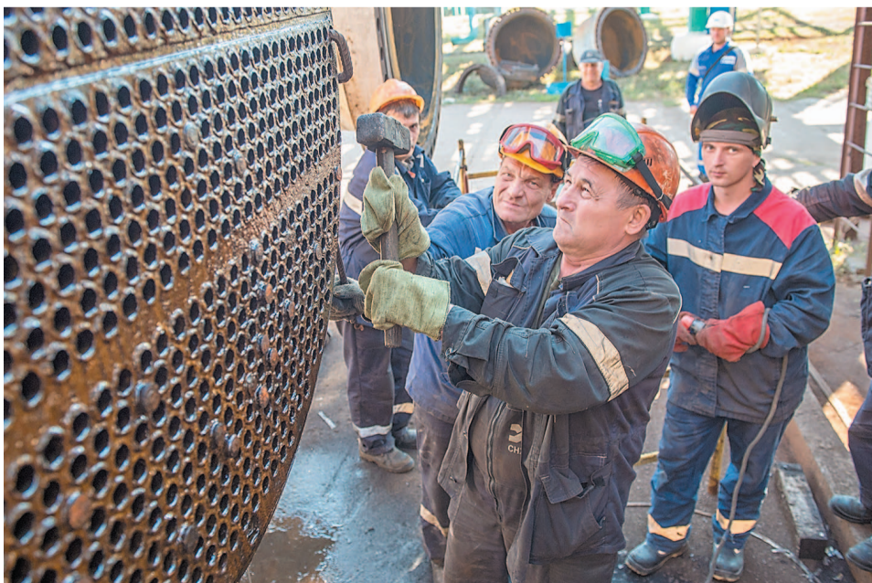
Демонтаж пучка теплообменного оборудования на установке ГО-4
