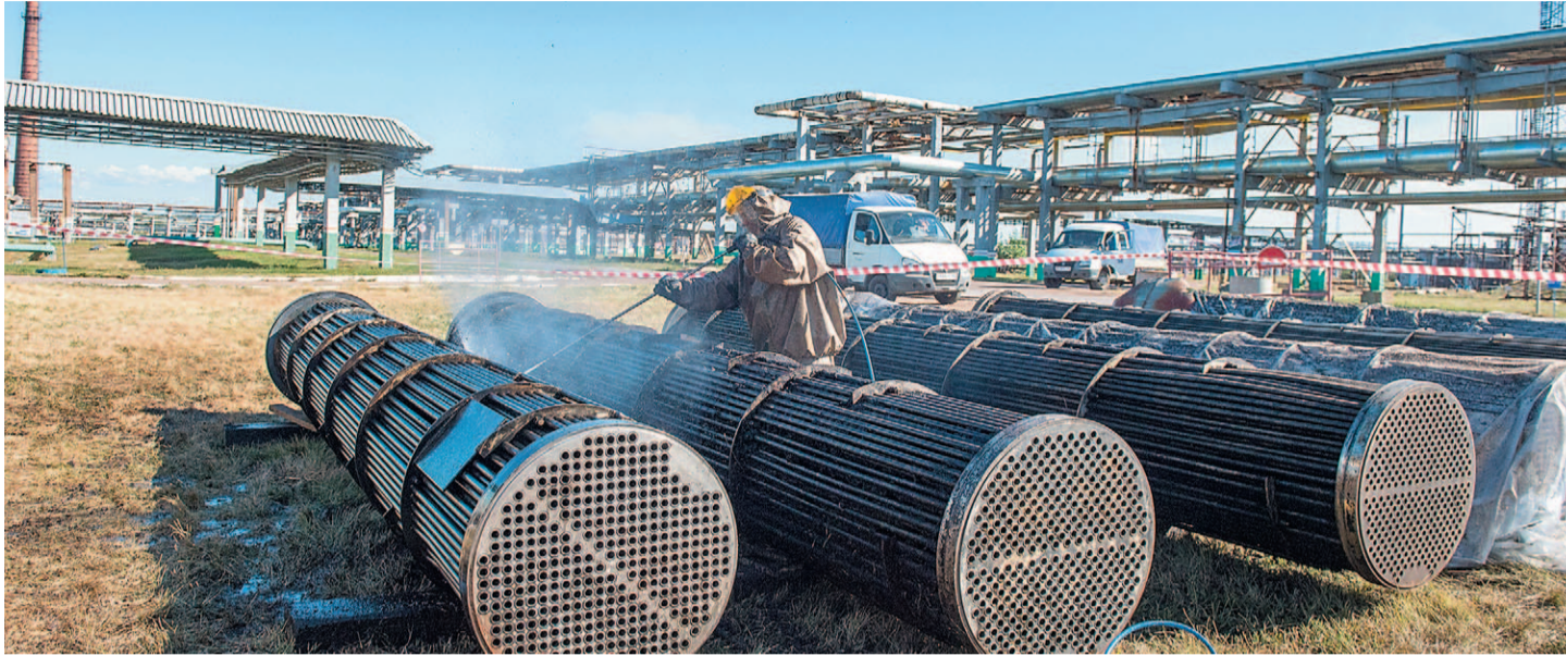
Чистка трубных пучков на установке Л-35/11-1000
