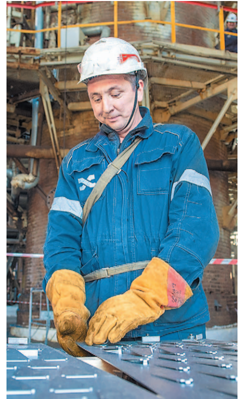
Замена внутренних устройств на колонне К-220 установки ЭЛОУ АВТ-4
