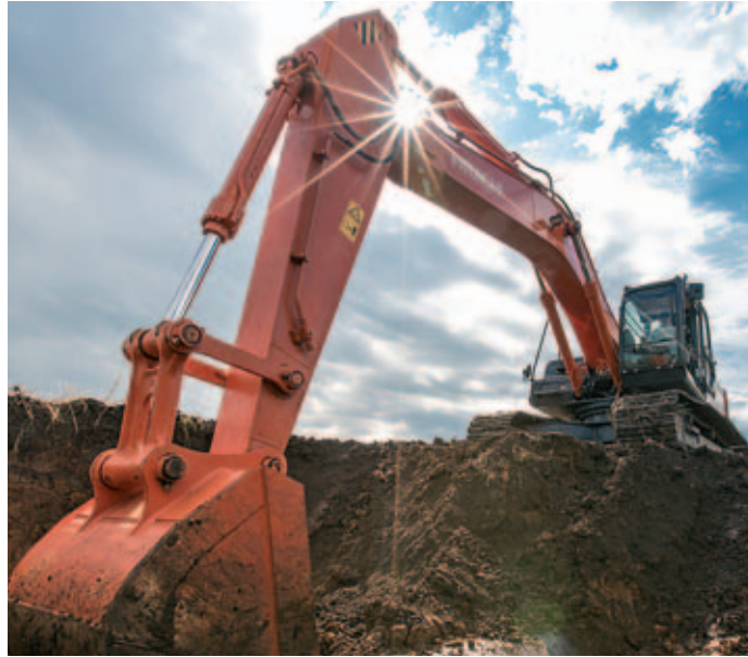
Во время замены крана на газопроводе-отводе к ГРС Карманово
