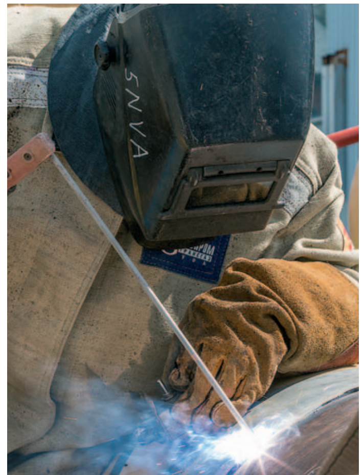
Сварные работы – один из самых важных этапов проведения ремонта
