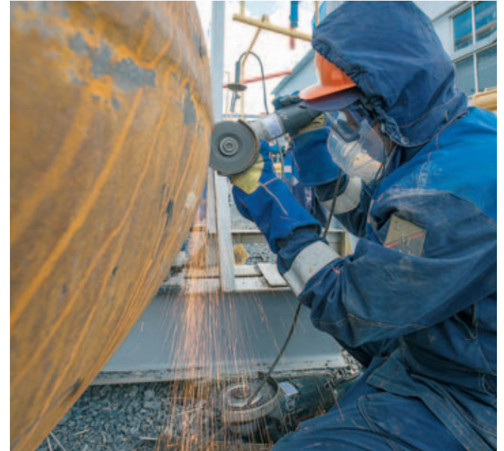
Надземная трубопроводная обвязка центробежных компрессоров компрессорной станции КС-19А Шаранского филиала требовала замены
