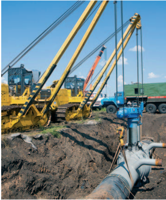
Замена шарового крана на газопроводе Поляна–КСПХГ
