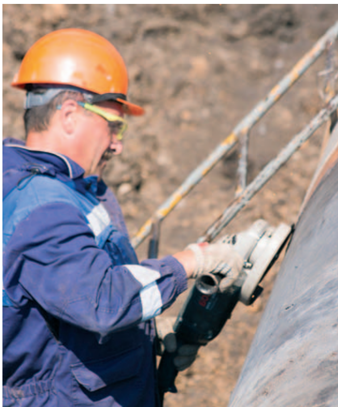
96 часов было отведено на выполнение работ на Кармаскалинском участке ремонта
