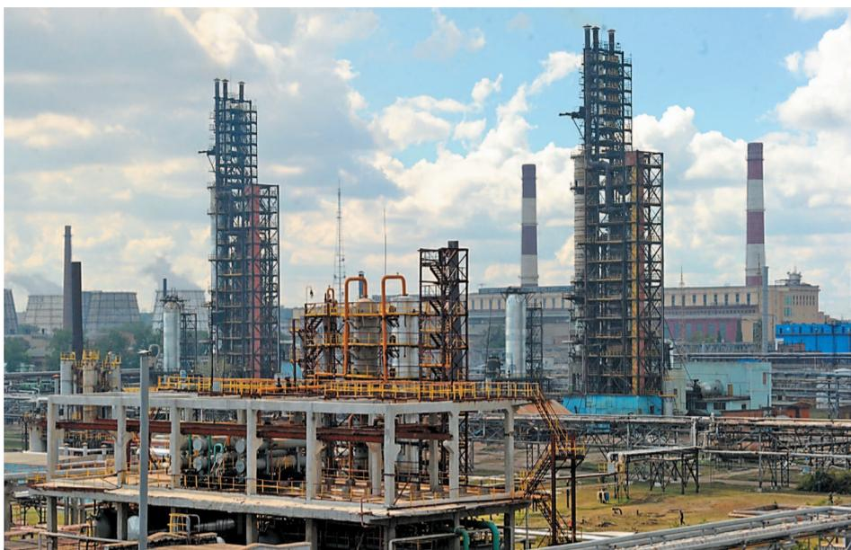
Установки каткрекинга — важное звено НПЗ, они обеспечивают вторичную переработку нефтяного сырья
