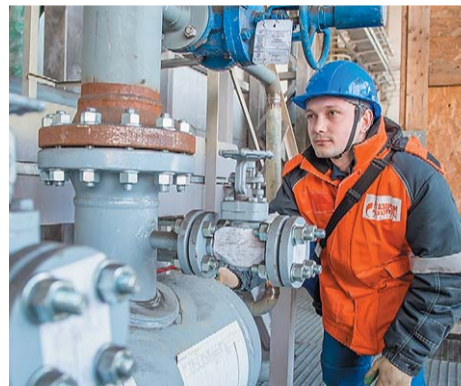
В компрессорной нового производства смонтирован фильтр продуктового водорода
