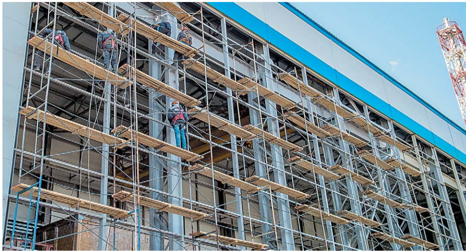
На площади в 720 квадратных метров восточной стороны компрессорной монтажники ведут установку алюминиевых конструкций под 200 стеклопакетов
