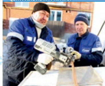
Слесари ЭРПГ Данис Семенов и слесарь ЭРГО Сергей Миронов одним из первых овладели секретами монтажа медных трубопроводов.
