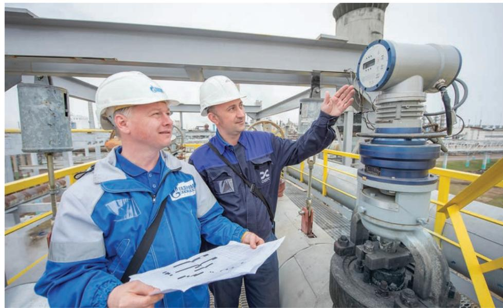
Устройство предназначено для транспортировки пара под давлением 14 МПа и температурой 560 градусов. Общая протяженность коллекторов П-140 ата составляет около четырех километров.
