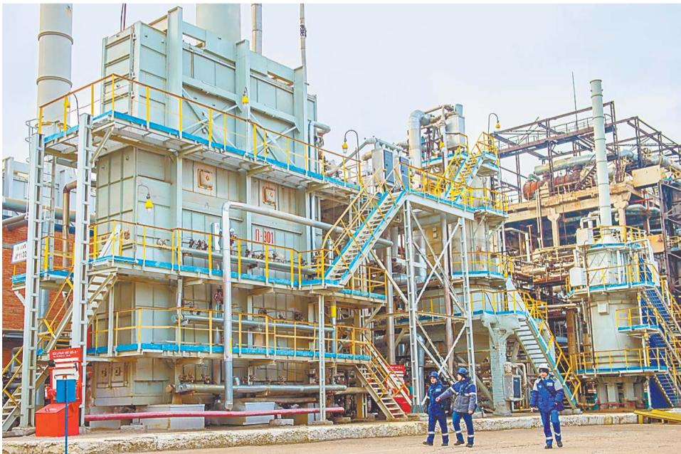
Блок печей и реакторов – один из важных объектов производства бензола
