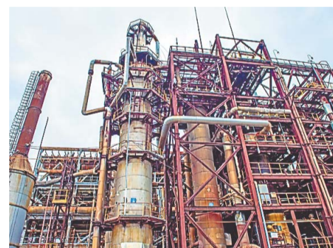
На колонне синтеза аммиака заменили внутренние устройства
