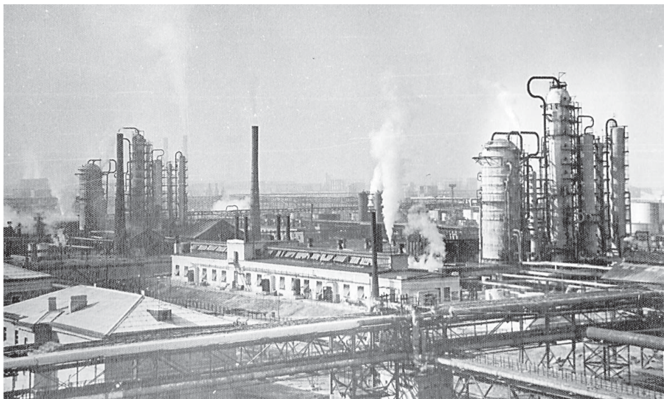
Установки АВТ-1 и АВТ-2 на салаватской промплощадке
