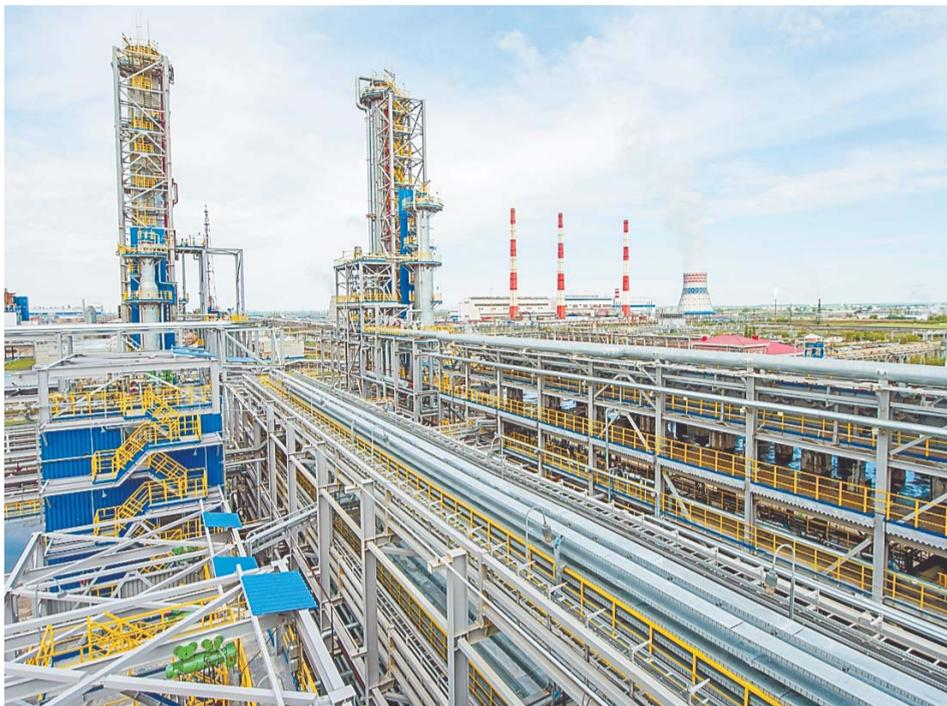
Общая производительность блока — 434 тыс. т/год. Сырьем установки служат низкооктановые бензиновые фракции C<sub>5</sub>-C<sub>6</sub>.
