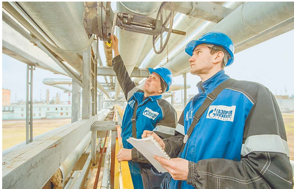
Участки трубопроводов или систем отопления, которые не выдержат испытания, будут отключены до устранения выявленных дефектов
