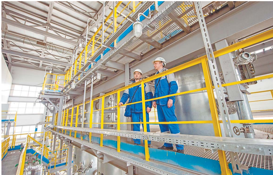
Уникальный проект установки СЦС позволит очищать стоки еще до сброса на очистные сооружения
