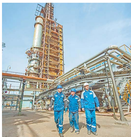
В цехе освоен большой объем ремонтных работ
